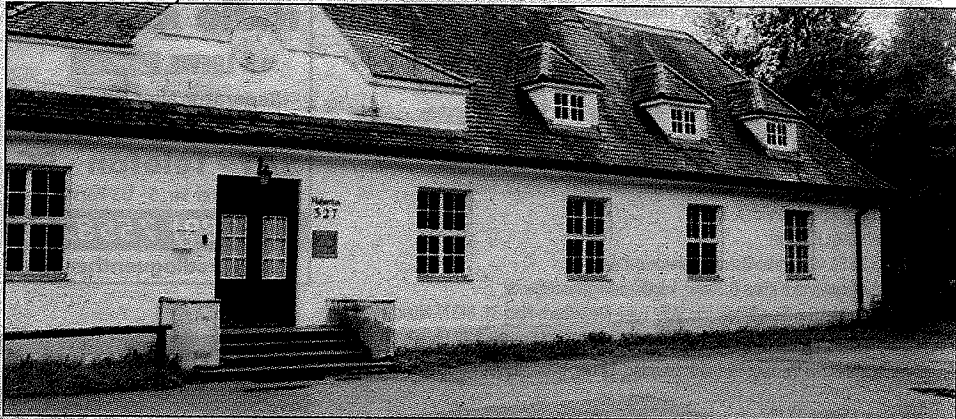
Das Forsthaus Hubertus im Forstenrieder Park; dahinter befindet sich die Schießanlage, die der Verein Hubertus für Jagd- und Sportschützen erweitern will. Der Verein wurde 1924 in Unterdill gegründet.
